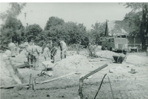
Mieszkańcy Wereszczyna podczas budowy remizy strażackiej - 1985r.
